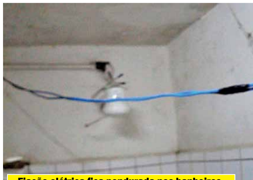
Fiação elétrica fica pendurada nos banheiros
