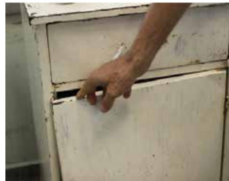
Mesinhas para pacientes enferrujadas e danificadas; armários para armazenagem de material e objetos de coleta sanguínea quebrados, sem portas ou enferrujados
